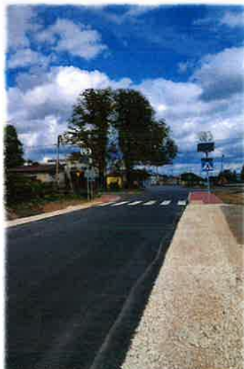
Foto 4. Droga powiatowa Nr 2920 E w miejscowości Jeżów, ul. Piotrkowska.
