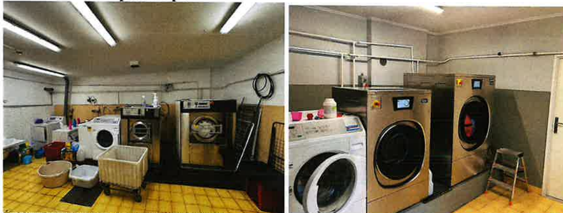
Foto 35. Pralnia przed i po remoncie
