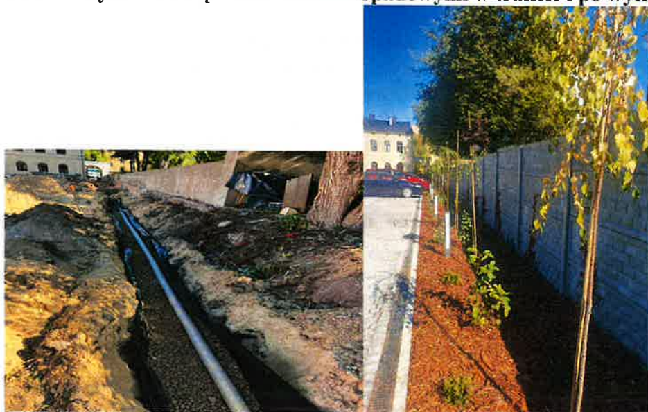
Foto 13. System zarządzania wodami opadowymi w trakcie i po wykonaniu.
