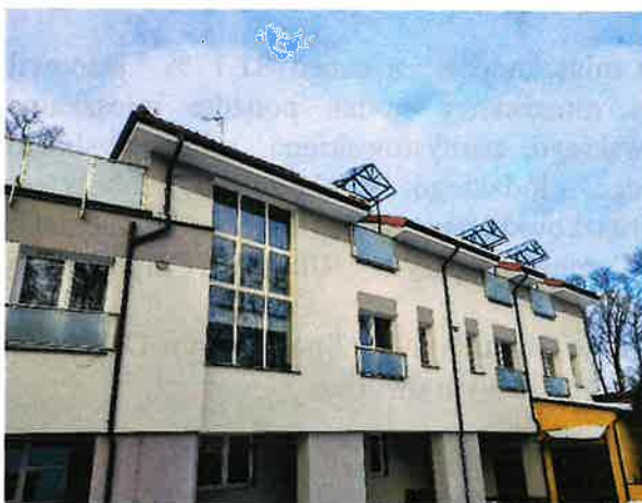
Foto 40. Po wykonaniu robót ....
