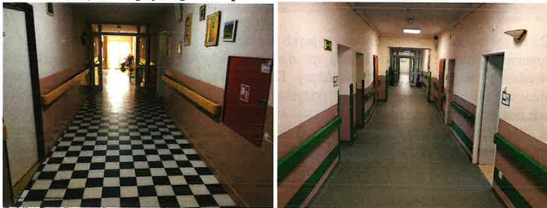
Foto 36. Korytarz I piętra przed i po remoncie.
