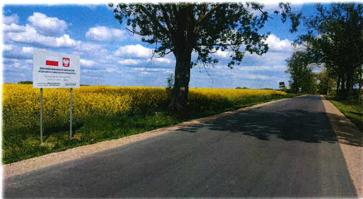
Foto 2. Droga powiatowa Nr 5103 E na odcinku Jeżów – Mikulin.
