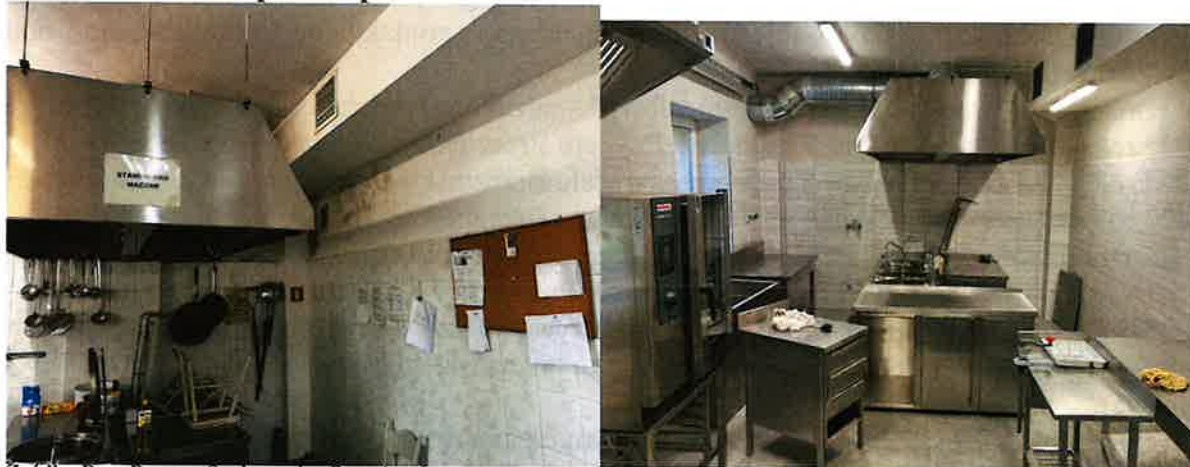
Foto 34. Kuchnia przed i po remoncie.
