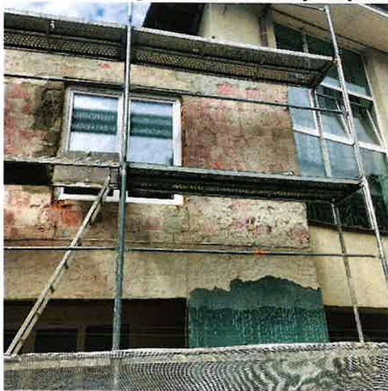
Foto 39. Docieplenie ścian zewnętrznych.
