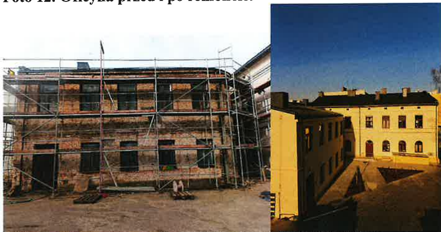
Foto 12. Oficyna przed i po remoncie.
